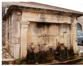
Javna fontana izgrađena 1581
